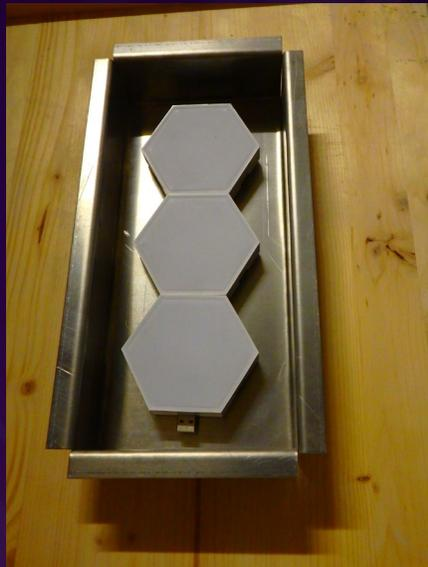
Als erste Maßnahme muss eine Aluminiumbox gemäß den Plänen in die Wandstruktur eingebaut werden. Dies wird später die Halterung für das LED-Panel sein. Der Elektriker führt die elektrische Zuleitung in diese Box. Das Aluminiummaterial gewährleistet die korrosionsfreie Haltbarkeit und den Schutz des Panels vor Feuchtigkeit und Wasser. Der Fliesenleger kann den Rand dieser Box mit einer Isolierung versehen, insbesondere in Badezimmern oder Wellnessbereichen.
